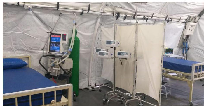
Chegada dos equipamentos e montagem do hospital de campanha do exército
